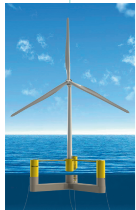
New England Aqua Ventus (NEAV) aux Etats-Unis (au large du Maine) • Capacité : jusqu'à 12 MW • Mise en service : 2025
