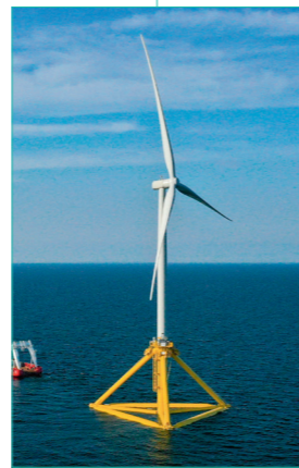
TetraSpar en Norvège (près de Stavanger) • Capacité : 3,6 MW • Mise en service : 2021
